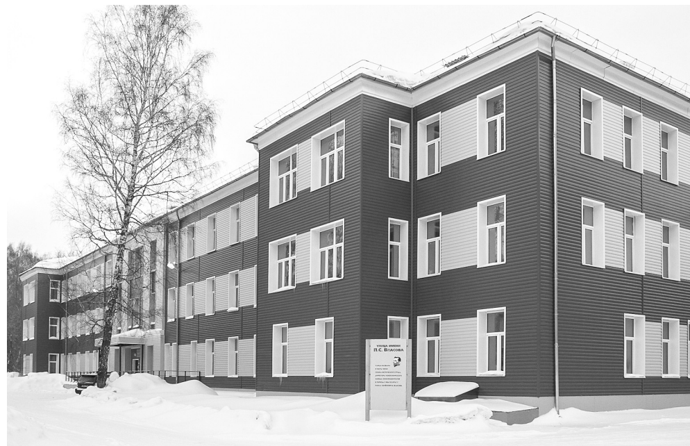
Сейчас компания «СберСтрой» работает с крупными муниципальными объектами: школами, детскими садами, больницами.
